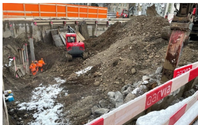
Baden (AG), Brown Boveri Platz 4 : excavation
