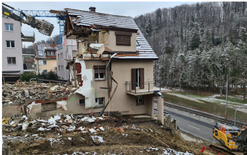
Zurich (ZH), Soodstrasse 90 à 96 : travaux de démolition
