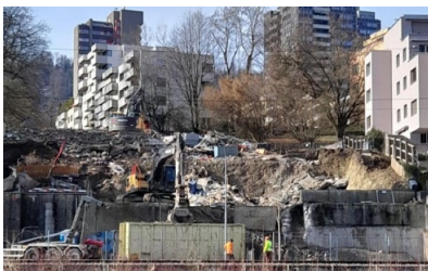
Zurich (ZH), Soodstrasse 90 à 96 : excavation
