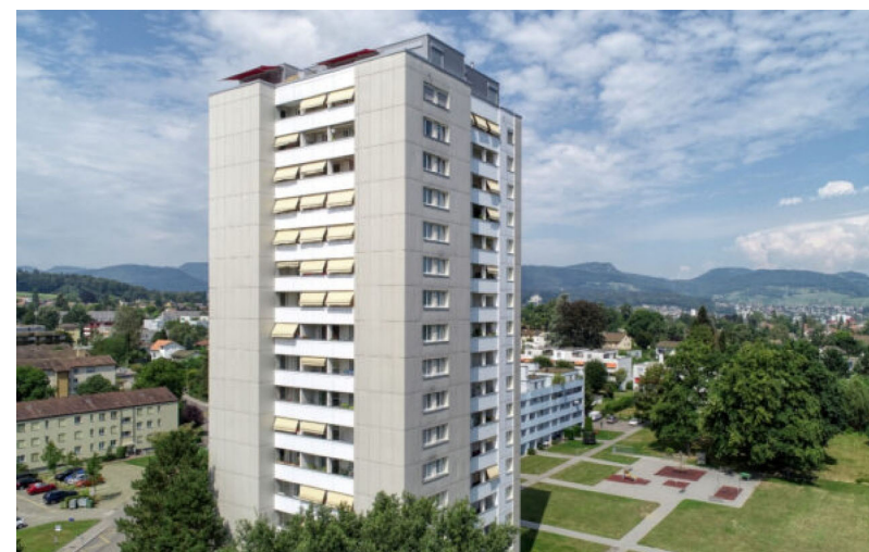
Aarau (AG), General Guisan-Strasse 31 | Année d'acquisition : 2019 | Valeur vénale : 27,76 millions de CHF | Logement
